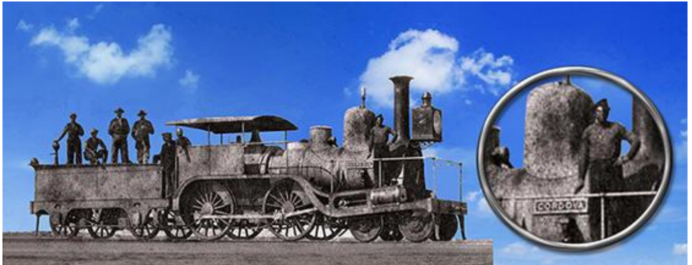
Locomotora "Córdoba 01" utilizada en las pruebas del tendido férreo entre Rosario y Córdoba
