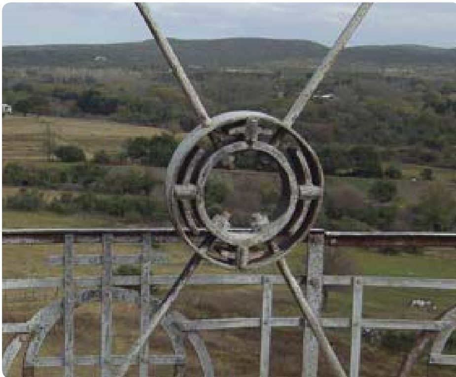
Detalle del aro de fijación de los tensores diagonales del molino
